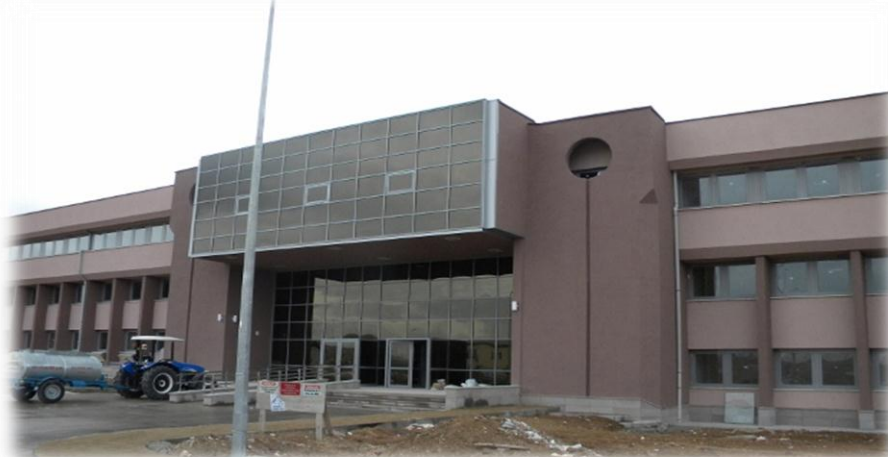
Gölbaşı Yerleşkesi BESYO Bina İnşaatı
